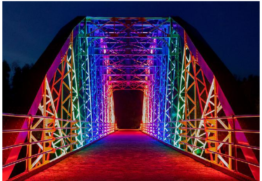
Puente de los Remedios, Villafranca de Cordoba 2022
